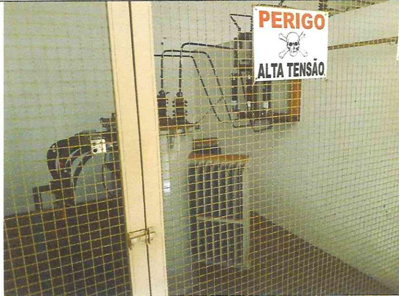
Existe sinalização de segurança que é realizada por meio de placa de advertência contendo os dizeres "PERIGO DE MORTE - ALTA TENSÃO", e indicação "Esta chave não deverá ser manobrada sob carga" junto a chave seccionadora.
