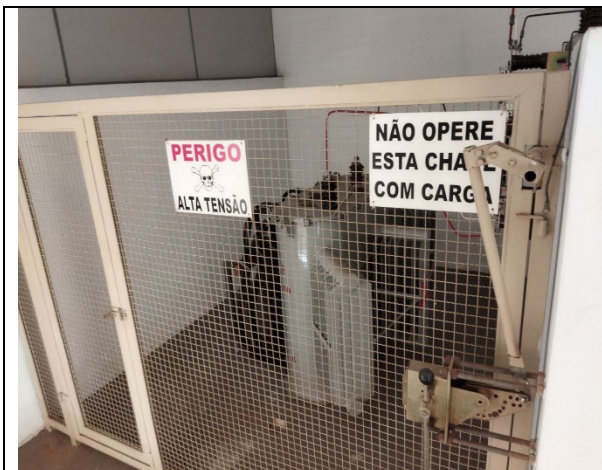
Transformador 500KVA
