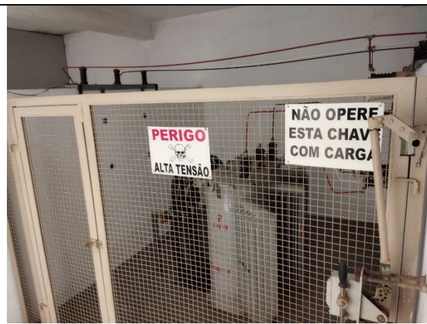
Transformador 300KVA
