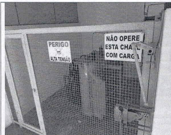
Transformador 500KVA
