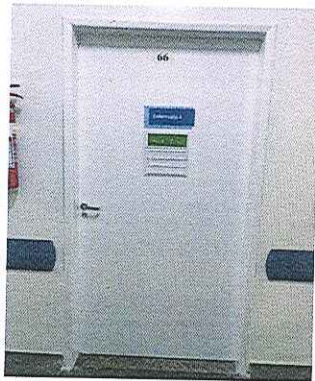
Figura 13 – Realizada pintura das portas.
