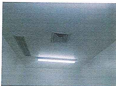
Figura 5 – Realizada limpeza das grades de ventilação.
