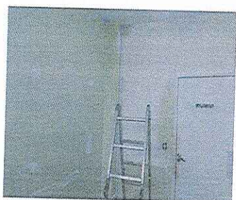
Figura 4 – Tratamento da infiltração na parede.
