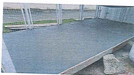
Figura 4 – Base concretada e regularizada.
