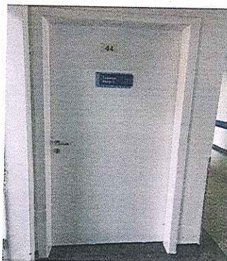
Figura 10 – Realizada pintura das portas.
