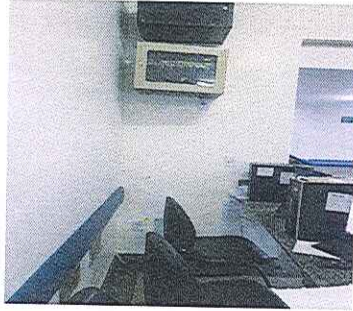
Figura 10 – Parede sem fiação exposta.
