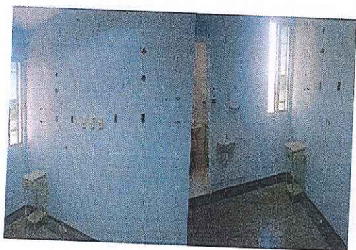
Figura 1 e 2 – Antes da realização dos serviços.
