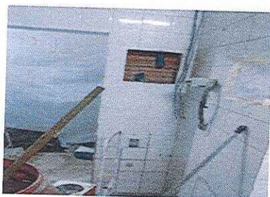
Figura 6 – Realizada a abertura do vão para instalação de filtro. Instalação do quadro com disjuntor.
