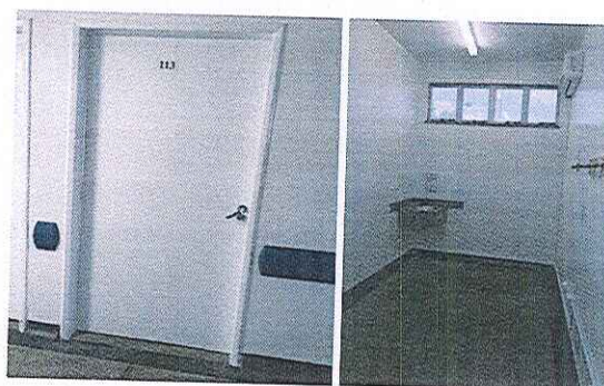
Figura 5 e 6 – Realizada pintura da porta. Realizada pintura e higienização da sala.
