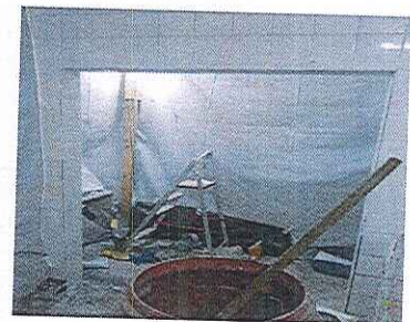
Figura 5 – Realizada requadrção do vão.
