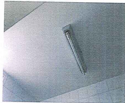
Figura 14 – Realizada a pintura do forro do posto de medicações.
