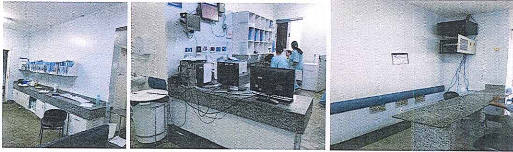
Figuras 1, 2 e 3 – Posto 1 antes da reforma.
