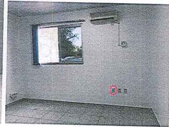
Figura 3 – Tampa da tomada de telefone instalada e proteção da fiação
