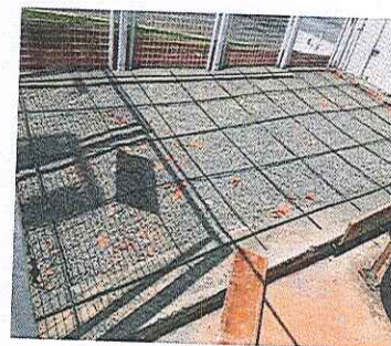
Figura 3 – Lastro de brita e malha de ferro já posicionada.
