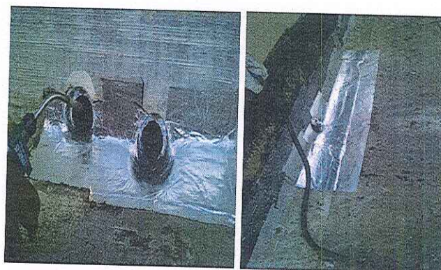
Figuras 2 e 3 – Tratamento da infiltração na laje.
