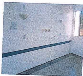
Figura 2 – Foto tirada depois dos serviços executados.
