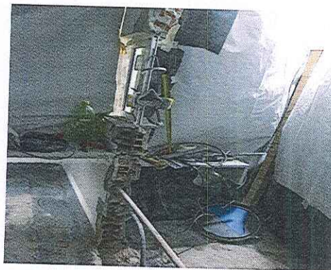
Figura 2 – Retirada bancada e janela.
