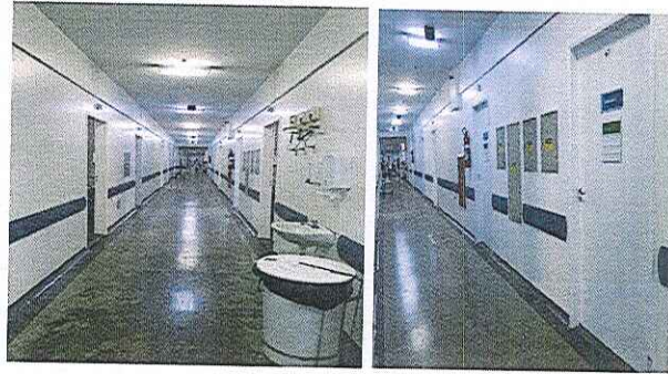
Figuras 11 e 12 – Realizada a pintura do corredor do posto 1.
