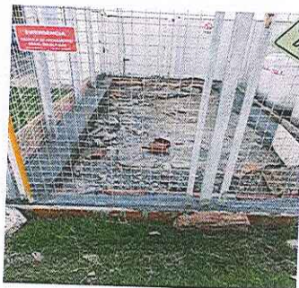
Figura 2 – Execução da viga baldrame.
