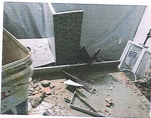
Figura 1 – Demolição de abertura do vão.
