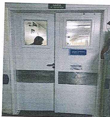
Figura 5 – Realizada pintura da porta.
