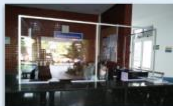
Assim como na recepção, as placas foram instaladas em vários pontos da unidade
