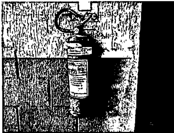
(c) EXTINTOR DE INCÊNDIO
