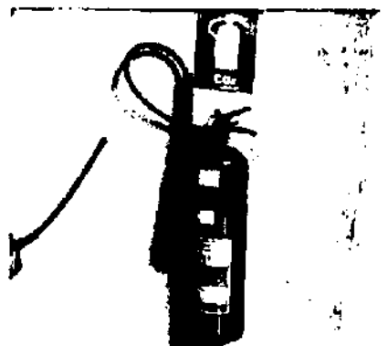
Extintor de incêndio
